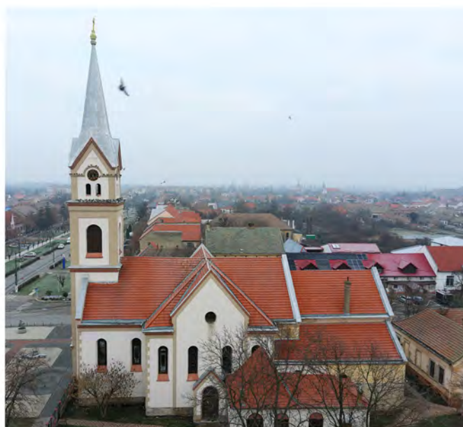
Fațada sudică a bisericii Acces secundar cu capela adosată
