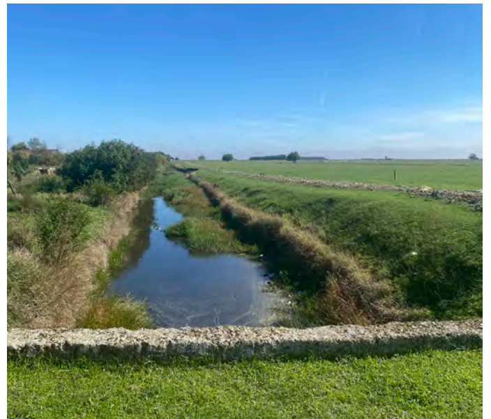
Jimbolia - canal perimetral fotografie: FAUT Timișoara
