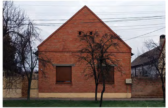
Fațadă din cărămidă aparentă Autor: FAUT
