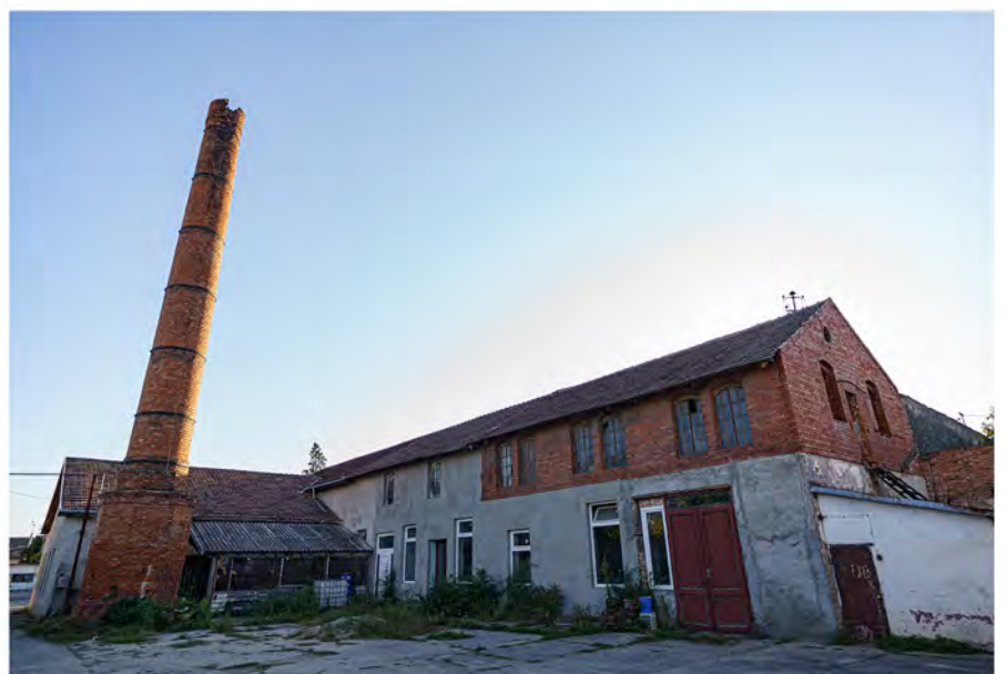
Ansamblul coș de fum și construcție (inițial din cărămidă aparentă), 2022. Autor: Theophil Soltes
