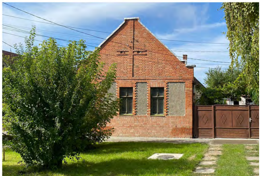
Fațadă din cărămidă aparentă, 2022. Auror: FAU Timișoara
