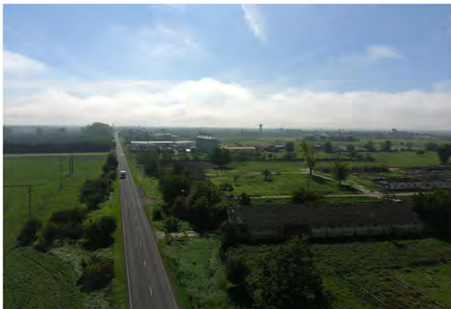
Vedere în lungul DN 59C - Calea Kikindei, intrarea dinspre Comloș, 2022. Autor: FAU Timișoara
