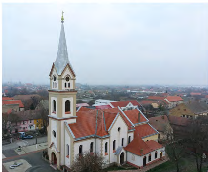
Perspectivă dinspre sud-vest, cu evidențierea capelei extinse pe latura sudică și volumetria profilată pe silueta orașului
