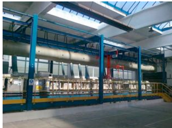
„Montare linie de zincare în hală existentă”, județul Hunedoara Beneficiar: SC CTS România SRL
