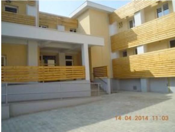
„Reabilitarea centrului de zi pentru copii cu dizabilități „Podul Lung” Timișoara” Beneficiar: Municipiul Timișoara
