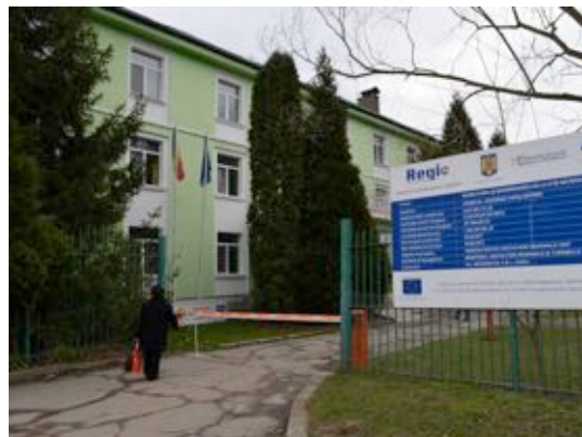
„Reabilitarea și modernizarea azilului de bătrâni Reșița” Beneficiar: Consiliul Județean Caraș-Severin
