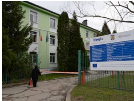
“Reabilitarea și modernizarea azilului de bătrâni Reșița”
